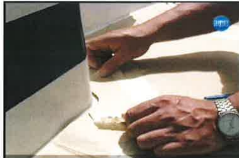
Abbildung 5: Aufkleben einzelner Rundungen
