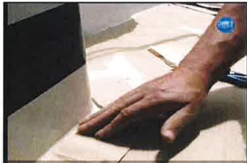
Abbildung 3: Zurückschlagen und Fixieren des überstehenden Randes
