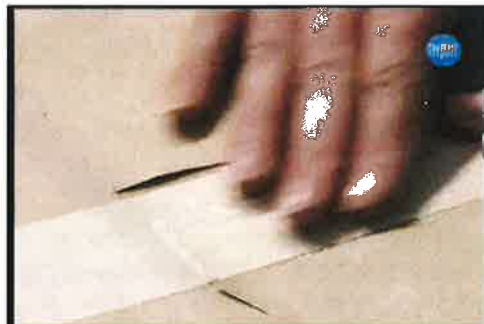
Abbildung 2: Fixieren der Schablone gegen Verrutschen
